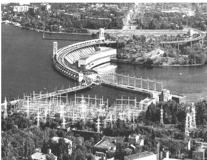
Рис. 2. Плотина Днепропольского водохранилища.
