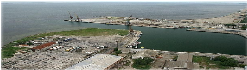
Рис.4 Будівництво порту міста Скадовськ.
