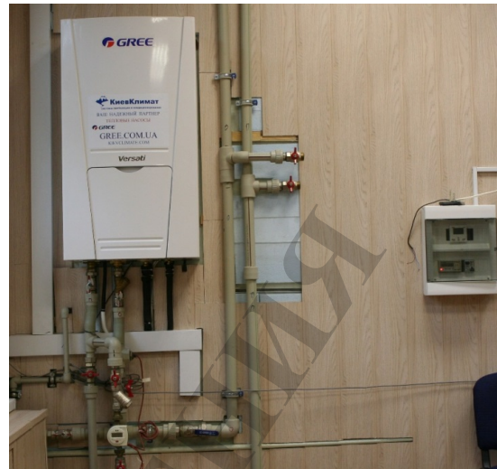
Рис. 17. Внешний вид теплового насоса сплит-типа «воздух-вода» тепловой мощностью 6 кВт
