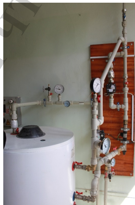
Рис. 18. Бивалентный водонагреватель-аккумулятор емкостью 300 л
