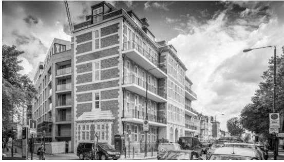
з'єднання історичного і нового корпусів лікарні
